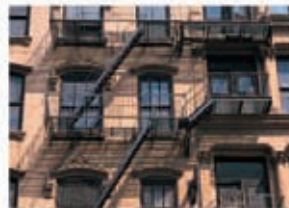
非常階段 hijō kaidan fire escape
