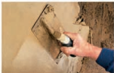
漆喰を塗る shikkui o nuru | plaster (v)
